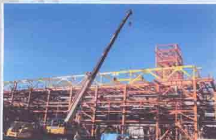
نصب اسکلت فلزی کوارهای هوایی ۲۰۰۱/۳۰۰۱
