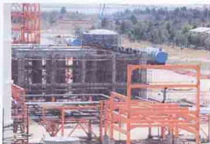
بتن ریزی Compressor Shelter
